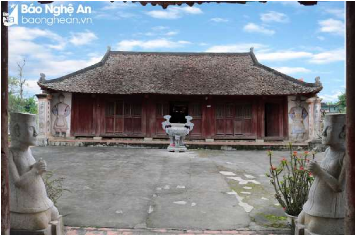
Sau những lần trùng tu, tôn tạo, đền Cả dường như vẫn lưu giữ được vẻ đẹp kiến trúc cổ kính nguyên sơ. Trong ảnh: Nhà hạ điện của đền Cả
